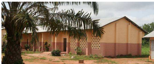
Construction et rénovation de bâtiments Ici à l'école primaire de Gbékandii II
