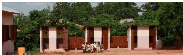
Construction d'urinoirs et de lavabos, adduction d'eau potable. Ici à l'école maternelle d'Adjohoun
